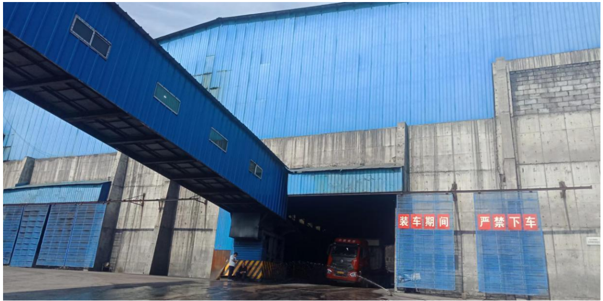
全封闭储煤场及皮带通廊
